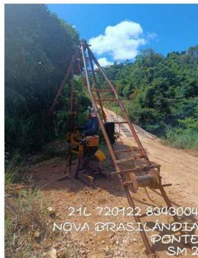
Foto 02 - Vista da execução da sondagem.
